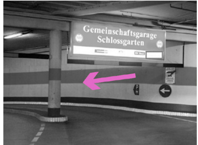
2) Einfahrt 1. Spindel nach unten. Durchfahrtshöhe ist 1,80 m.
